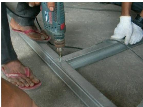
Gambar 5. Pemasangan dan Penyambungan Profil
