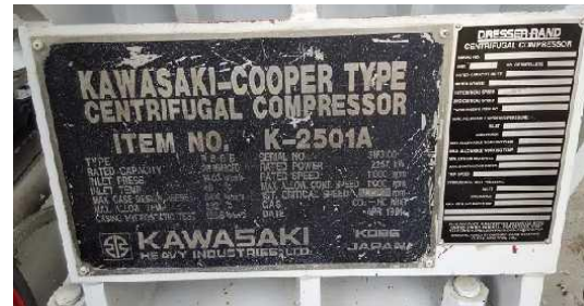
Gambar 6. Spesifikasi kompresor ( Sumber : PT ARUN NGL )
