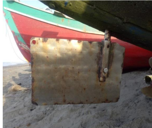
Gambar 2. 4 Korosi sumuran pada daun kemudi perahu
