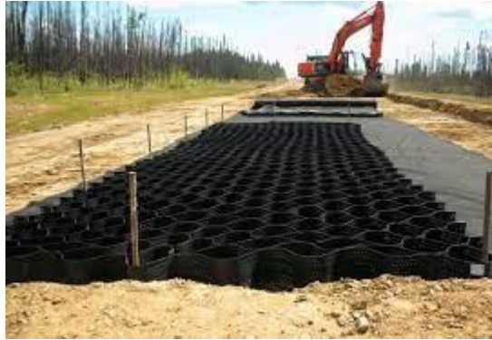
Gambar 1 Geogrid pada lapisan jalan
