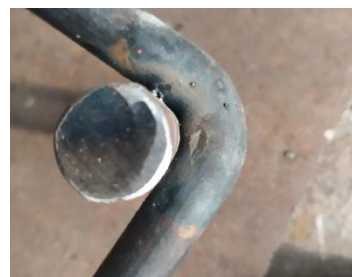
Gambar 6. Proses fit-up spesimen sebelum dilakukan proses pengelasan.
