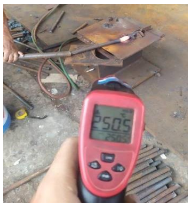
Gambar 5. Proses hot bending menggunakan brander oxy-acetylene
