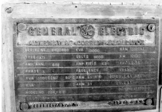
Gbr. 8 Nameplate GE Alternating Current Generator Pada PT PGE
