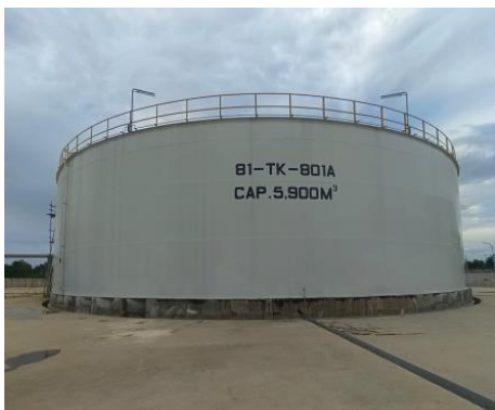
Gbr 1. Tangki Penyimpanan Sulphuric Acid
