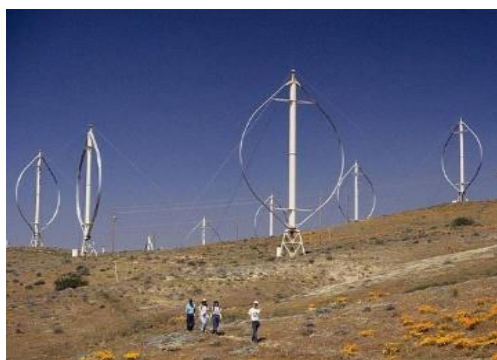
Gbr. 3 Turbin Angin Sumbu Vertikal
