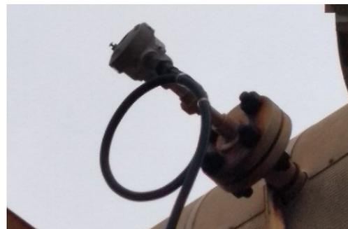
Gambar 2 *Thermocouple* (PT. Perta Arun Gas)
