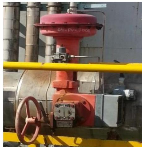
Gambar 2 Control Valve FV – 4509
